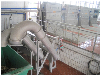
Zulaufrechenanlage
